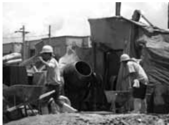
Figura 4. Una fuente de ruido en las obras. Una concretadora o mezcladora es generadora de ruido, sobreesfuerzos y material particulado.
