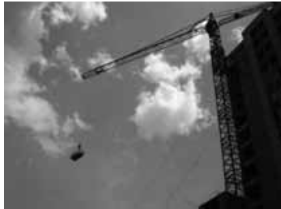
Figura 6. Trabajo en alturas en una torre grúa, utilizada para transportar materiales en la construcción.
